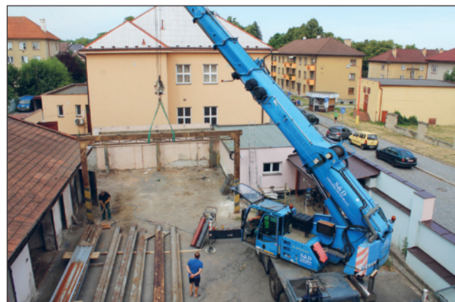
☐ V červenci začala rekonstrukce dvora městského úřadu.
