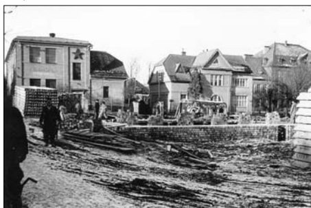
V roce 1961 probíhala stavba družstevní bytovky v ul. ČSA.
