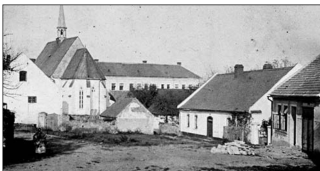
☐ Teprve po demolici se prostor u špitálku otevřel do nám známé dnešní podoby.
