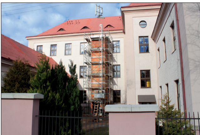
□ Kolemjdoucí mohou pozorovat, jak pokračuje výstavba výtahu, která zajistí bezbariérovost budovy ZŠ Komenského.
