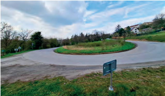
Rekonstrukce silnice v úseku Skuteč – Štěpánov by- chom se měli dočkat v příštím roce.
