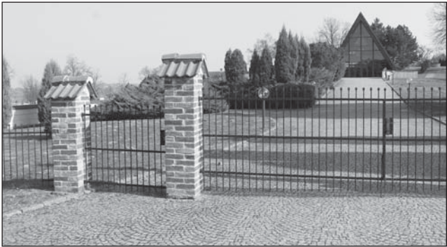
Ve smuteční síni bylo opraveno ozvučení a naplánovaná je také oprava hřbitovní zdi z této strany areálu, kde odpadala část obkladů.
