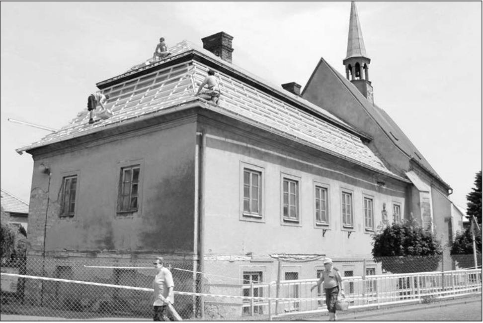
Zhotovení nové střechy na Špitálku zajišťuje po vyhraném výběrovém řízení firma Jaroslav Kopřiva Skuteč. V horkých červencových dnech nebylo zaměstnancům firmy co závidět.
