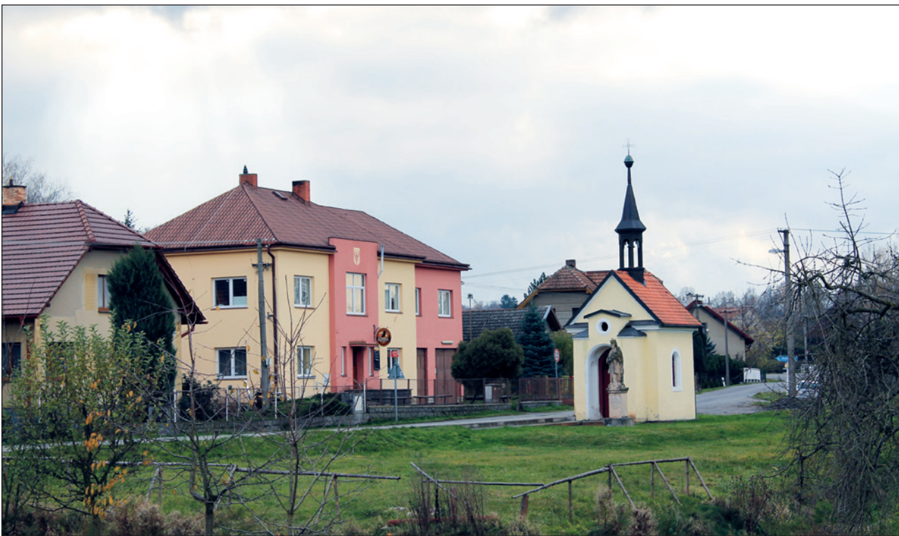
□ Listopad v Radčicích – centrum obce s kapličkou zasvěcenou sv. Václavu, hlavnímu patronovi země České. Postavena byla v roce 1880, kdy jsou v obci na potoce Raná připomínány velké povodně.
