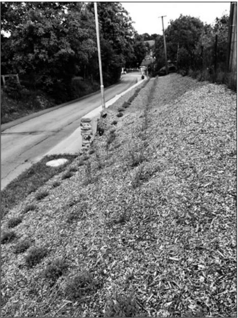
U nového chodníku ve Žďárce bylo vysazeno 265 ks keřů.
