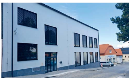
❑ Nejnovější a největší investicí je nová městská knihovna a kreativní centrum. Kromě stavby a vybavení budovy byla upravena komunikace a chodník z přední části, v té zadní vznikl prostor pro venkovní akce i odpočinková zóna a nezbytná parkovací místa.
