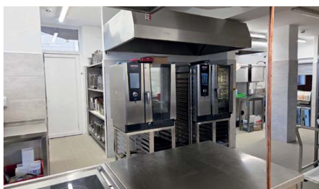
❑ Vedle vybavení energeticky úspornými spotřebiči prošla kuchyně SeniorCentra kompletní rekonstrukcí zahrnující i nové rozvody vody a kanalizace (náklady přes 9 mil. Kč). Za více než 3 mil. Kč byla budova vybavena elektrickou požární signalizací.
