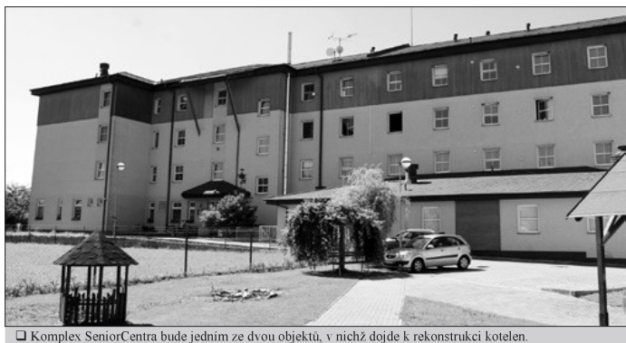
□ Komplex SeniorCentra bude jedním z dvou objektů, v nichž dojde k rekonstrukci kotelen.
