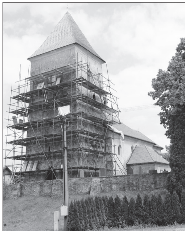
☐ Komplettní rekonstrukce kostela sv. Václava v Lažanech pokračuje opravou fasády věže. Při té příležitosti se využije postaveného lešení a nátěrem bude ošetřena šindelová střeška.
