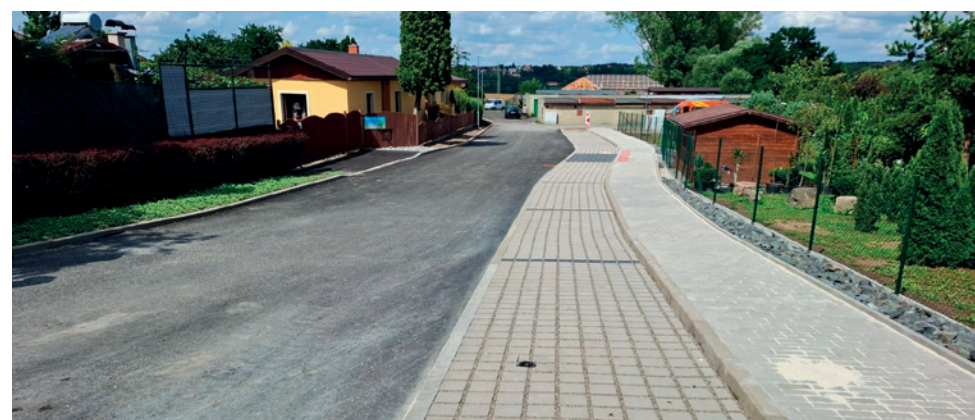
Nová příjezdová komunikace ke garážím a stavebním pozemkům.
